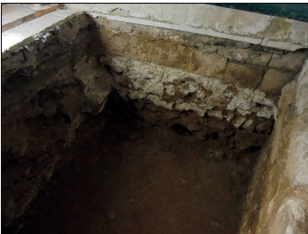
Fotografia 24: empremta de calç blanca del mur UE 17 a la cimentació de la paret oest de l'edifici.
