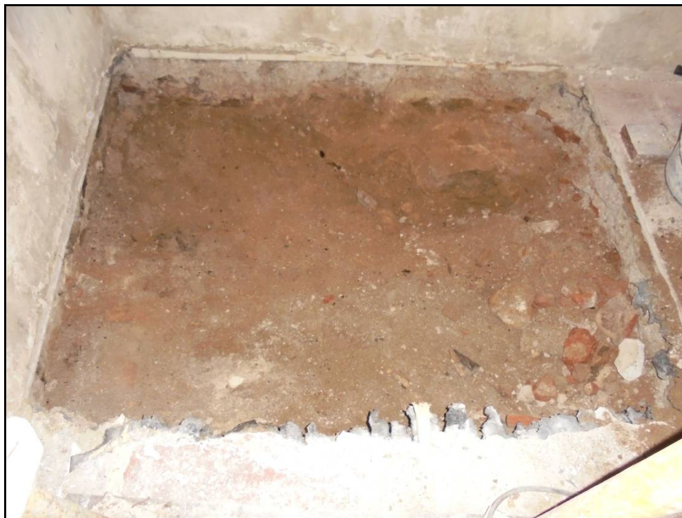
Fotografia 10: Caixa de l'ascensor sense la pavimentació de rajoles.
