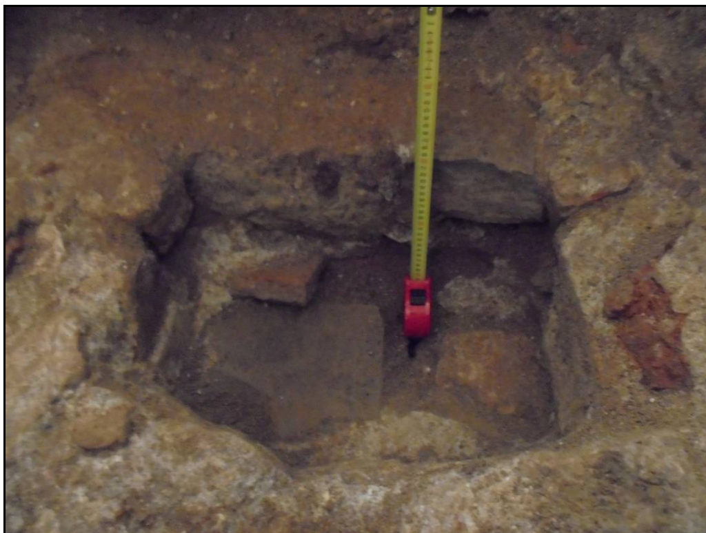
Fotografia 18: Fons del dipòsit buidat de sediment.
