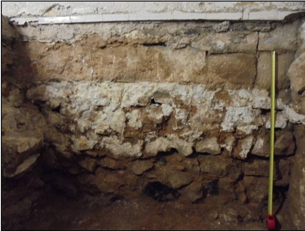
Fotografia 13: Fonaments de la paret oest de la finca (UE 13).
