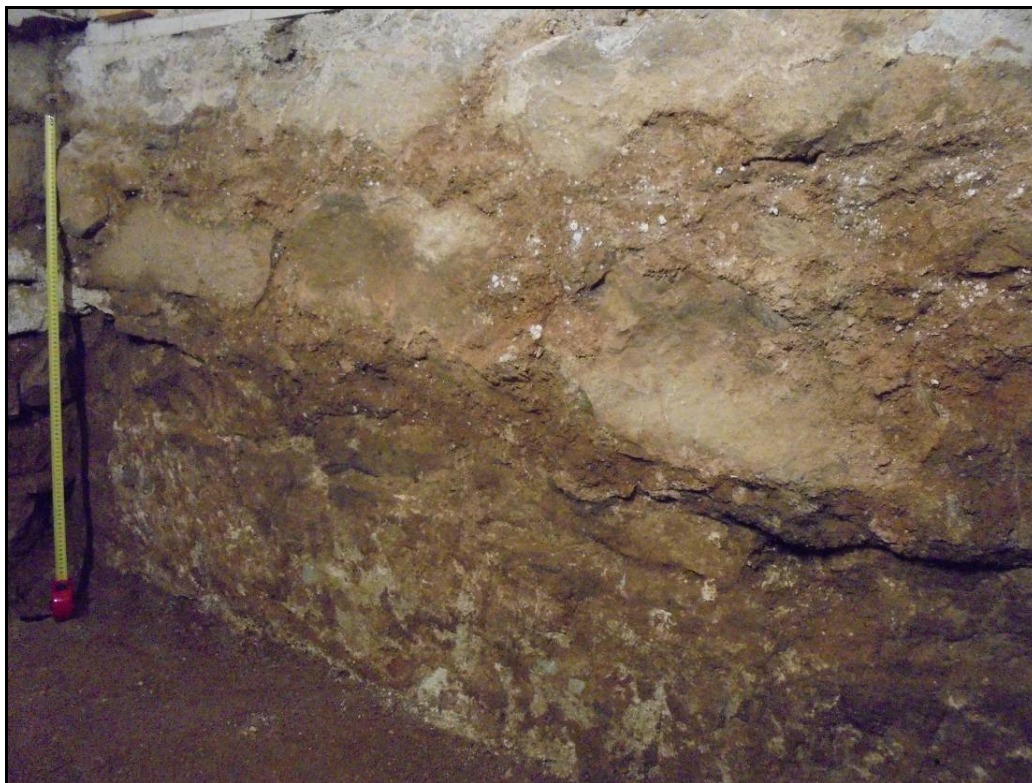
Fotografia 14: Fonaments de la paret oest de la finca (UE 15).
