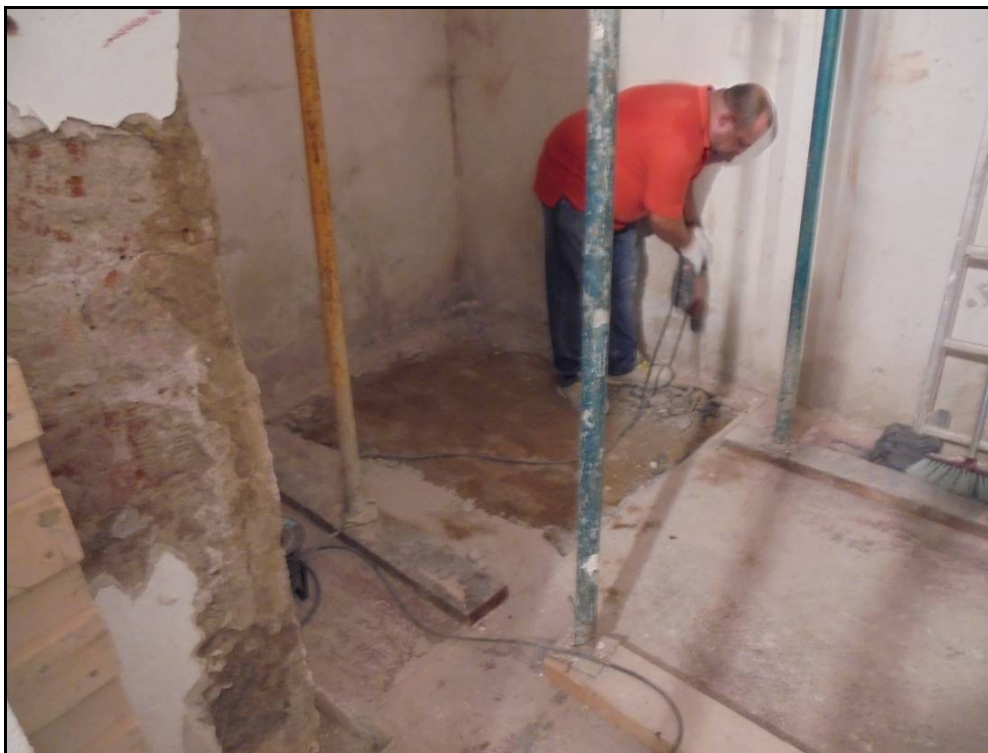
Fotografia 9: Trencament amb martell elèctric del paviment al lloc d'instal·lació del nou ascensor.
