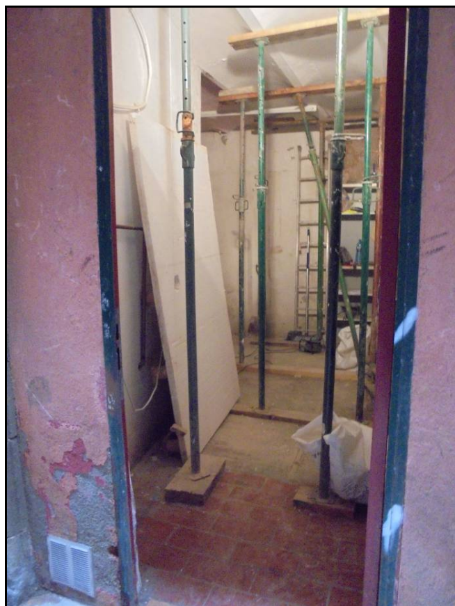
Fotografia 8: Interior de l'àmbit de intervenció, vist des de l'entrada.
